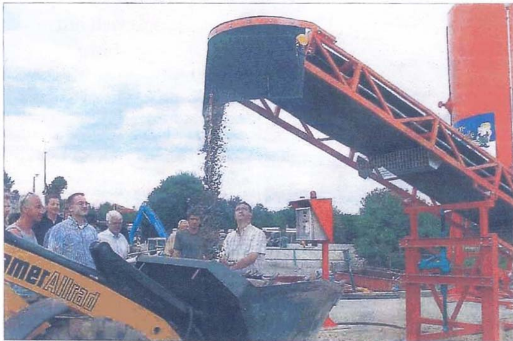
Leise rieselt der Beton: Die erste Tankstelle Schleswig-Holsteins ging gestern in Süsel in Betrieb. Thilo Gollan (4. vo. li.) hat sie gekauft, Karl-Heinz Schreiber (rechts) konstruiert. Foto: Krauskopf
